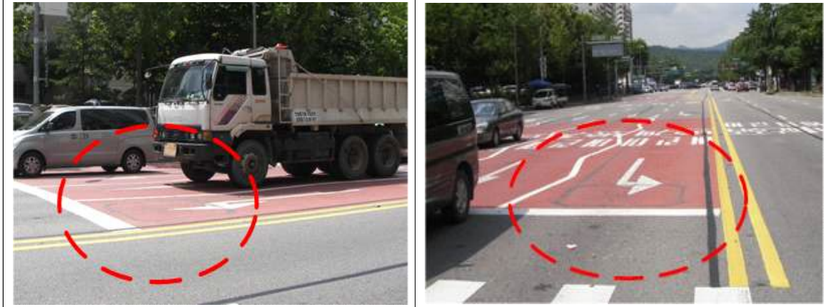
[그림 4-47] 좌회전 차로 검지기 설치 사진
